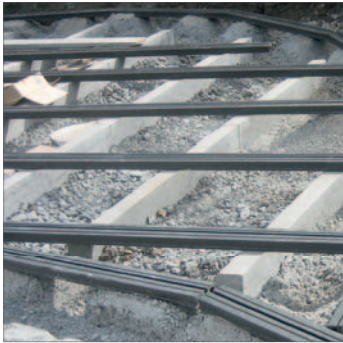
Montage auf Randsteinen
