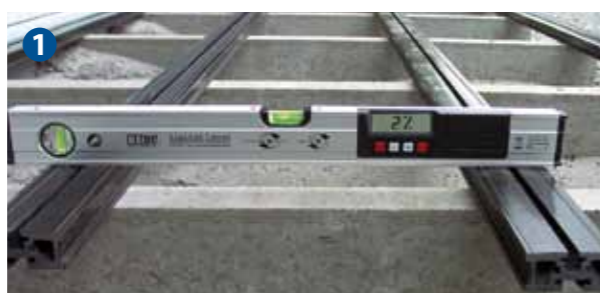
1 Untergrund vorbereiten und Unterkonstruktion befestigen.
